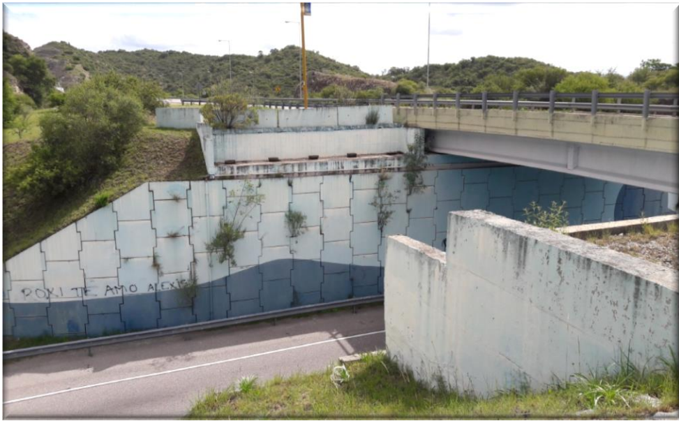
Ensanche Puente en RP A 73
