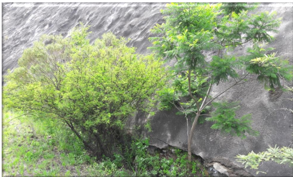
Vegetación al costado de la banquina
